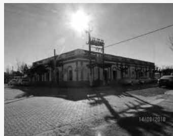
Vivienda rural (sobre RP 26)
